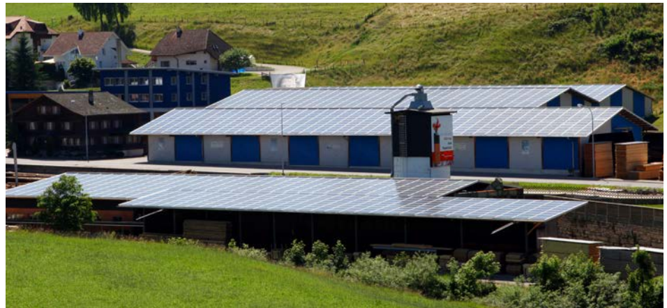
Abb. 3: Dieses Sägewerk im Luzernischen Luthern erzeugt dank seinen vollflächig installierten Solaranlagen 450% mehr Energie, als es für den Betrieb pro Jahr benötigt. Die Solarstromüberschüsse - selbst im nassen Jahr 2013 rund 150'000 kWh/a - werden ins öffentliche Netz eingespeisen. (Foto: Solar Agentur Schweiz)
