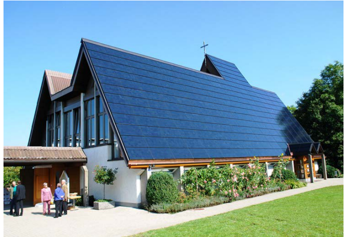
Abb. 3 und 4: Diese mit dem Schweizer Solarpreis ausgezeichneten Bauten weisen den schweizweit höchsten Energieertrag pro m 2 Dachfläche auf. Die Usine Solaire der Société d'Énergie Solaire im Kanton Genf (links) erzeugt 183 kWh/m 2 a. Die PV-Anlage der Solarkirche Halden (rechts) generiert sogar 192 kWh/m 2 a.
