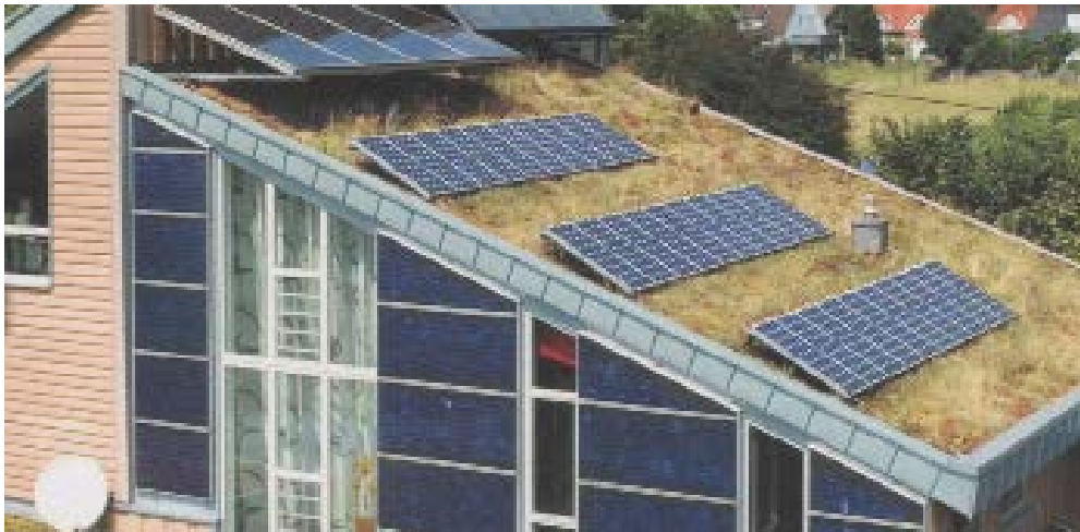
Abb. 2: Diese Anlage überragt die Dachfläche um 10-15 cm. Solche Anlagen will die neue RPV gemäss Art. 32a Abs. 1 lit a zulassen!
