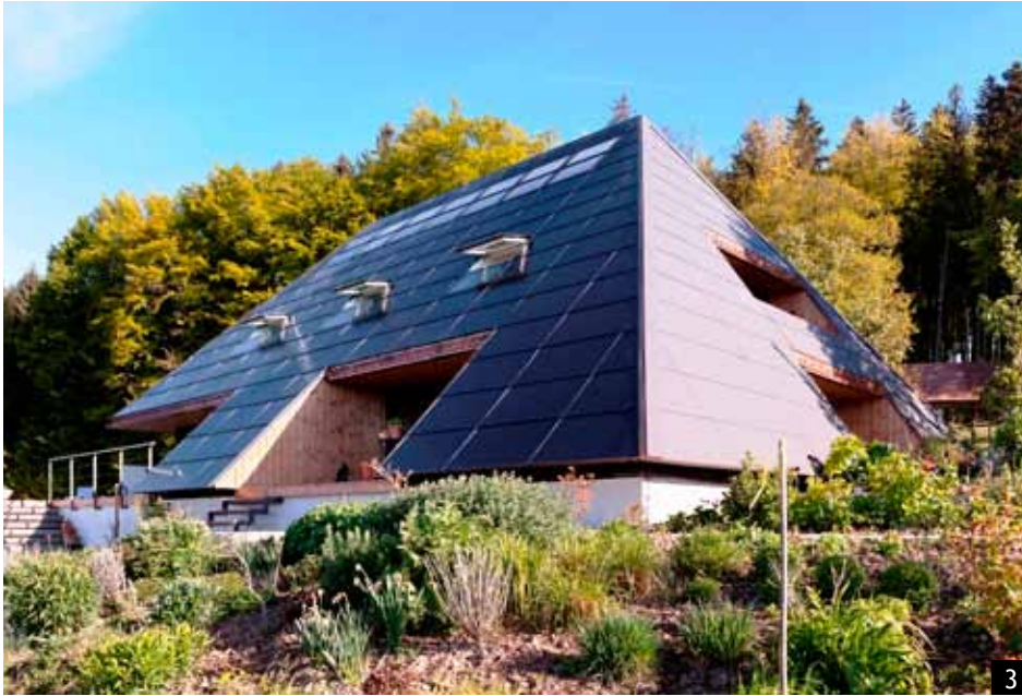
Abb.3: Der Energiebedarf dieses Baus wurde durch eine Sanierung von 60 720 kWh/a auf 12 150 kWh/a reduziert. Dank einer Solaranlage beträgt die Eigenenergieversorgung nun 177% (Foto: Solar Agentur Schweiz, 2012).
