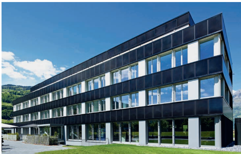
Abb. 3: Dieser Verwaltungsbau in Flums/SG konsumiert seit der Sanierung mit 99'000 kWh/a 71 Prozent weniger als vorher (340'000 kWh) und produziert dazu noch 114'000 kWh/a. (Foto: Solar Agentur Schweiz)
