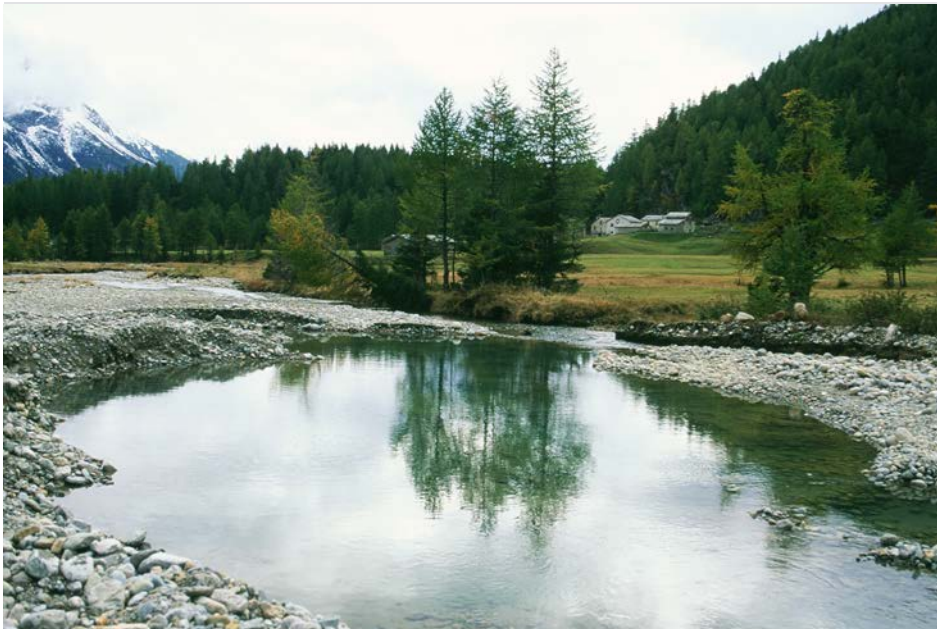
Abb. 3: Die vorbildliche Gewässersanierung in der Cavaglia-Ebene/GR mit Kiesinseln und unterschiedlichen Fließgeschwindigkeiten bietet (Lebens)Raum für Wasser, Pflanze, Tier und Mensch. (Foto: SGS)
