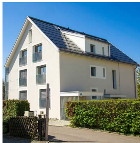
Abb. 4: Seit der Sanierung verbraucht dieses Vierfamilienhaus in Oberengstringen/ZH nur noch 18'800 statt 66'800 kWh/a und produziert sogar 5'700 kWh/a mehr, als der Bau und seine Bewohner benötigen - ein 131%-PEB! (Foto: SAS)
