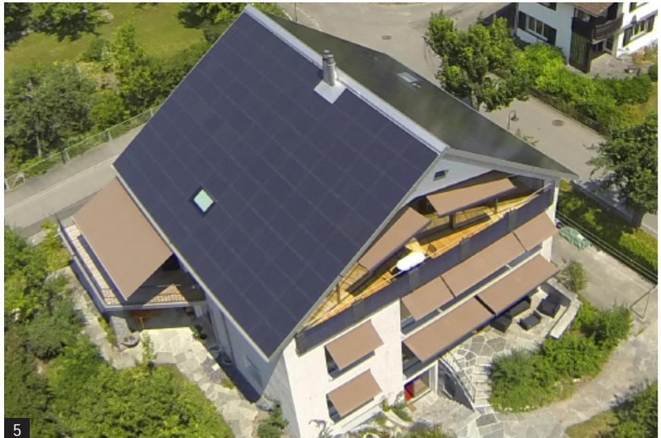
Abb. 5: Das mit dem Schweizer Solarpreis 2013 ausgezeichnete Mehrfamilienhaus in Thun/BE konsumierte vor der Sanierung fast 80'000 kWh/a. Heute benötigt es noch 20'600 kWh/a - und erzeugt 38'500 kWh/a Solarstrom. Die Eigenversorgung beträgt 187%, trotz Ausbau von 2 auf 3 Wohnungen. (Bild: Solar Agentur Schweiz)
