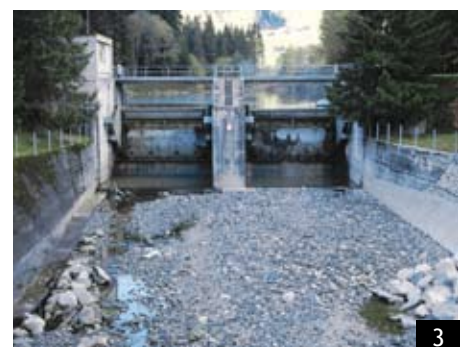
Abb. 2-5: Von der AXPO/NOK trockengelegte Flüsse: Surettabach oberhalb Andeer/GR / Val Russein/GR / Rein de Plattas/GR / NOK-Stauwehr bei Sedrun/GR
